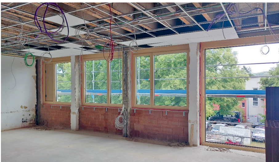
Der Fenstereinbau hat begonnen.
