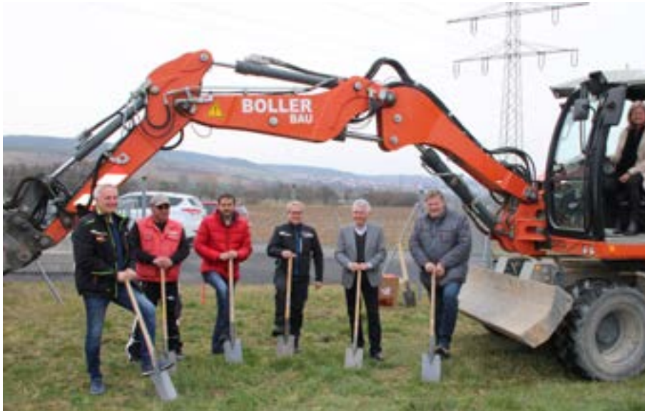
v.l.: Michael Zwingmann (Boller-Bau GmbH, Bauleiter), Thomas Wieczorek (Boller-Bau GmbH, Polier), Zoltan Szlaninka (Bauamtsleiter), Andreas Baumann (Mitarbeiter des Eigenbetriebes Abwasserbeseitigung), Georg Mohn (Mohn Ingenieure Ingenieurgesellschaft mbH), Michael Boller (Boller-Bau GmbH) und am Steuer: Bürgermeisterin Anette Schmidt
