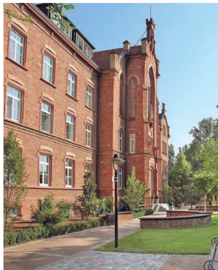
Zuletzt war es das „Hotel St. Michael“. Das Gebäude wurde als erzbischöfliches Knaben-Konvikt erbaut und war späterer das erzbischöfliche Studienheim St. Michael.
